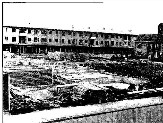
Fundering van 'Het Anker'. Op de achtergrond, het is 6 juni 1956, het winkelcentrum Capelle-West in aanbouw. Foto: archief gemeente Capelle aan den IJssel.
