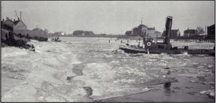
De sleepboot/ijsbreker 'Deutschland' onder grote belangstelling aan het werk ter hoogte van het voetveer naar de scheepswerf van C. van der Giessen & Zonen in de Krimpense Stormpolder. De links aan de Nijverheidstraat gelegen panden maken deel uit van de reparatiewerf van A. Vuyk & Zonen's Scheepswerven. Achter de 'Deutschland', voetgangers die zich ondanks de nabijheid van de ijsbreker op het ijs begeven en de in 1928 gereali-seerde villa van scheepswerfdirecteur Cornelis van der Giessen aan de Krimpense Schaardijk. Foto: collectie HVC-Beeldbank.
