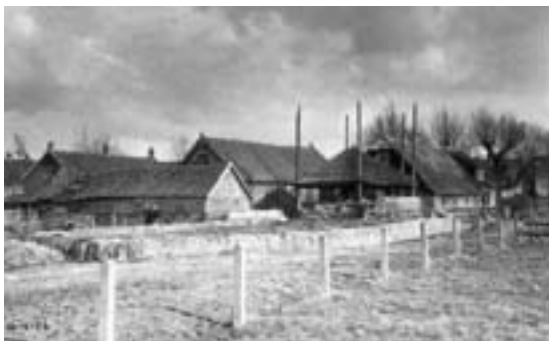
De eerste werkzaamheden om de landerijen achter deze boerderij bouwrijp te maken zijn inmiddels gestart.
