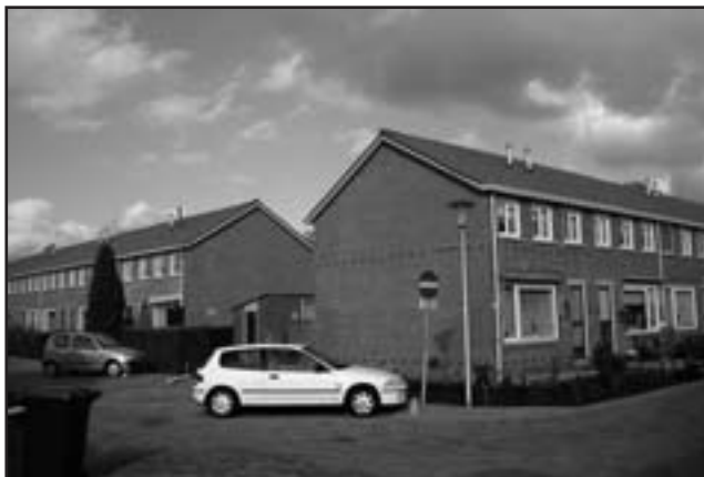
1e socialewoningbouw in de burg. Verloopstraat (Middelwatering - Oude Plaats), gebouwd in 1944
