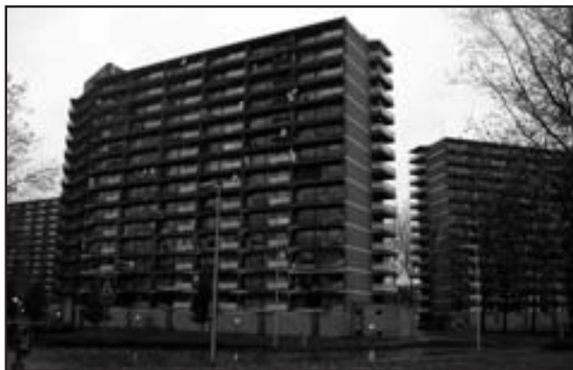
Galerijwoningen aan de Hoeken in Oostgaarde, gebouwd in 1968
