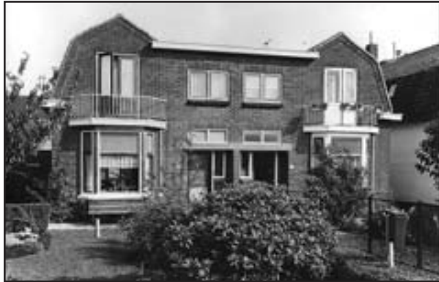
De dubbele woning aan de Kerklaan 54 en 56.
