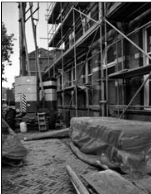
De Van Capellenstichting in de steigers tijdens de restauratie.
