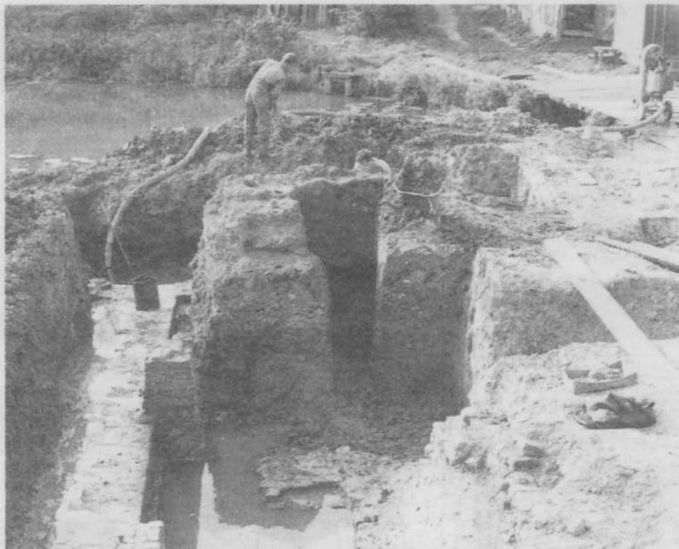
Opgravingen rond 1965. Rechts de fundering van de zuidelijk donjonmuur (± 1285) en links de muur om het laatste kasteel (vanaf 1612). Beide komen terug in de 'reconstructie'. (Foto: HVC)
